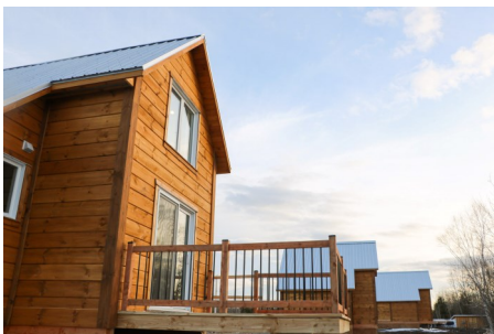
Chaque chalet a une galerie devant et un patio derrière.
